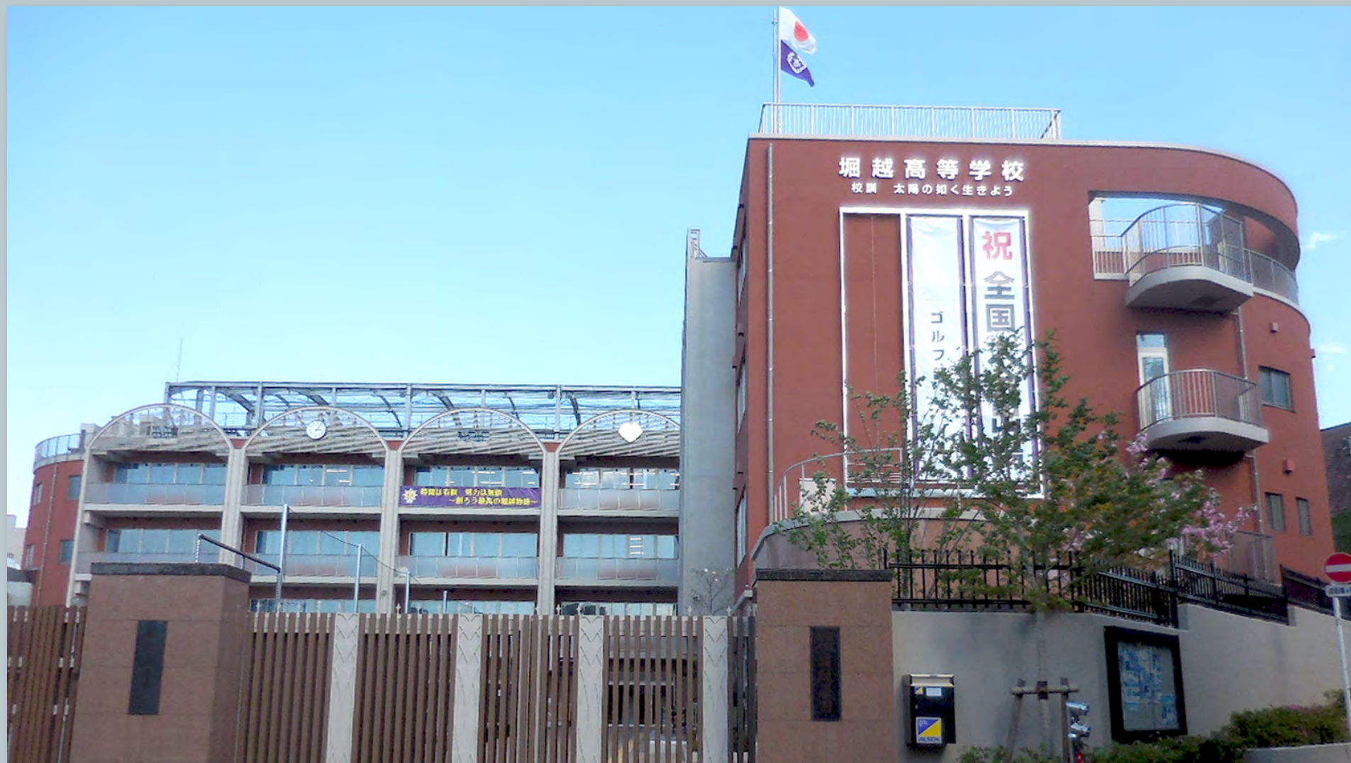
堀越学園新築工事
